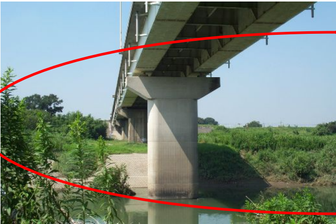
写真-1 : 手前より P3, P4, P5 橋脚
