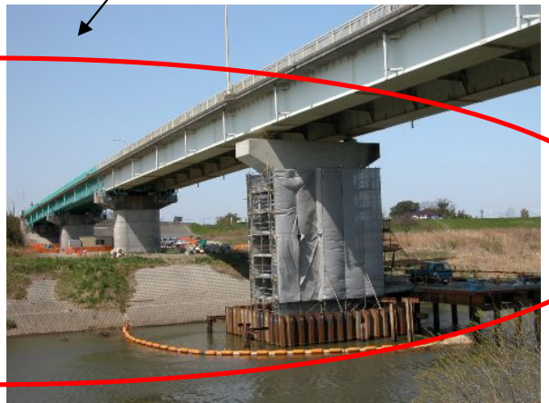
写真-2 : P3 橋脚 (施工中)
