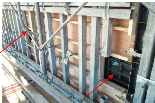
写真-3（生コン投入穴）
