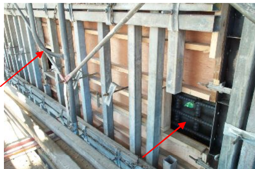
写真-3（生コン投入穴）
