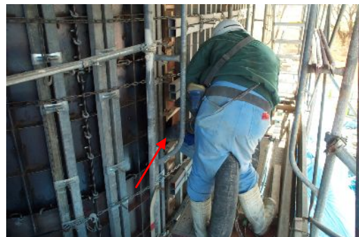
写真-4（打設状況）
